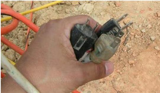
*¡Nunca uses cables de extensión que tengan patillas quebradas o faltantes!*
