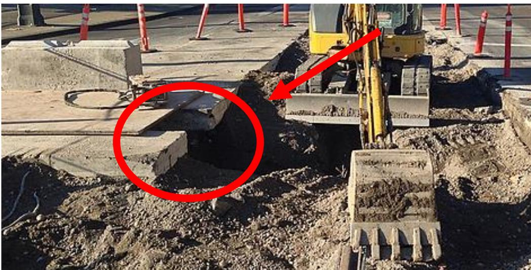
*El camino de concreto puede ser considerado un estorbo en la superficie. Nota que la excavación debajo del camino requiere apoyo.*
