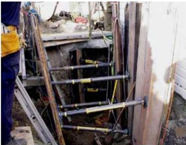
Escena de un derrumbe de zanja fatal después de que se instaló protección para derrumbes para remover el cuerpo del trabajador fallecido de manera segura.
