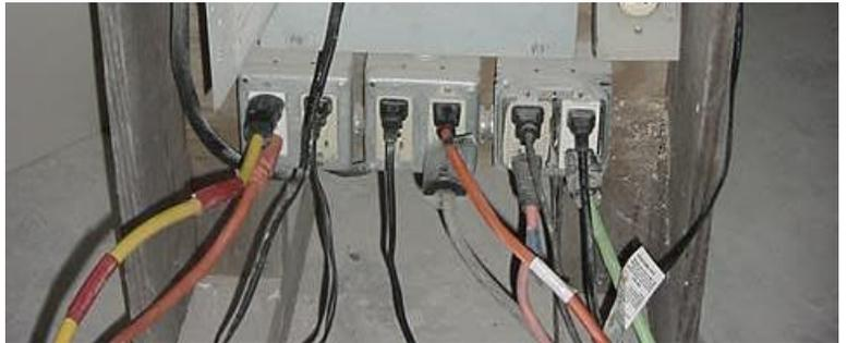
*Preparación temporal común de un panel eléctrico con tomas de corriente GFCI encontrados en un sitio de construcción.*
